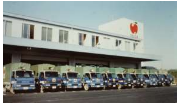
名護支所の外観
