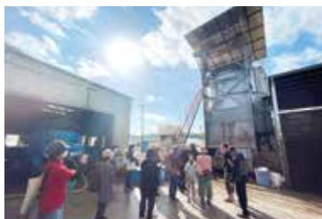
約30トンの専用タンク(コンポスト)で20~30時間かけて生ごみを発酵させて有機堆肥を製造
